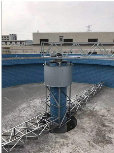
刮泥机，是一种将淤泥从河道里清理出来的一种机器，用于城市污水处理厂、自来水厂以及工业废水处理中直径较大的圆形沉淀池中，排除沉降在池底的污泥和撇除池面的浮渣。刮泥机由驱动装置、工作桥、主刮泥装置、辅助刮泥装置、中心转盘、撇渣装置、溢流堰板和挡渣板、集电装置等组成。对于中心进水周边出水沉淀池，一般还需设置导流筒。用于为达到沉淀排泥效果。那么，刮泥机是如何进行日常的维护和保养呢？刮泥机的维护和保养方法：1. 每月至少检查一次刮泥机的机械，电气功能。2. 每周检查刮泥机上所有螺栓，若出现松动现象应立即进行紧固。3. 每检查导向轮有无损坏，并调整好导向轮位置，保证刮泥机不走偏。4. 驱动电动机耐磨轴承应用
